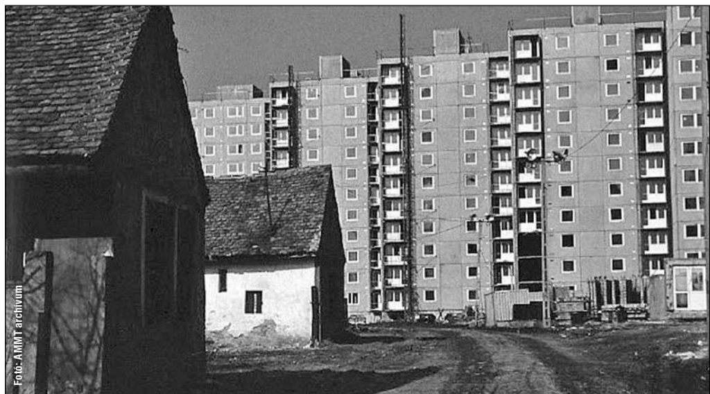
Tolnai utca építése
